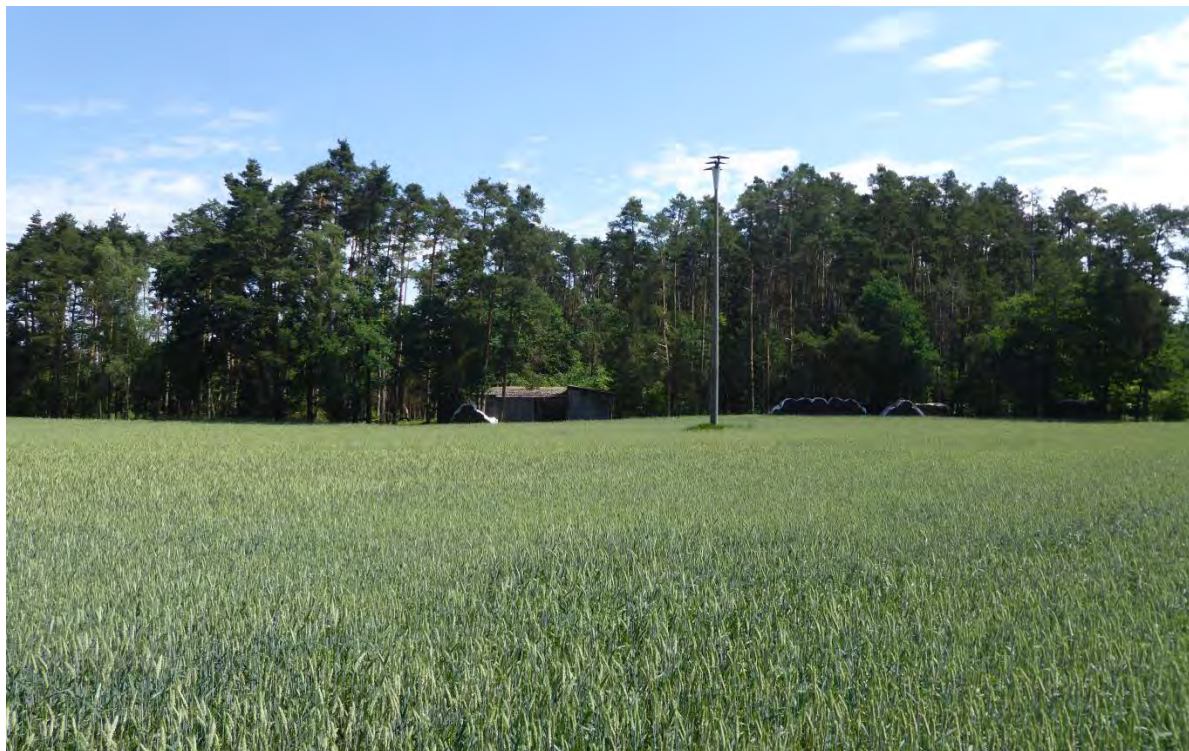
Abbildung 2: Blick von Nordwest auf die 20 kV-Leitungstrasse und den angrenzenden Kiefernforst
